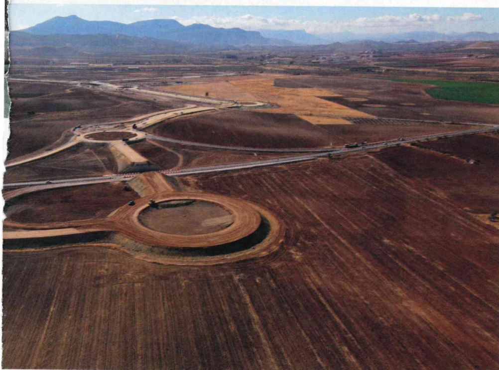
Estado actual de las obras
